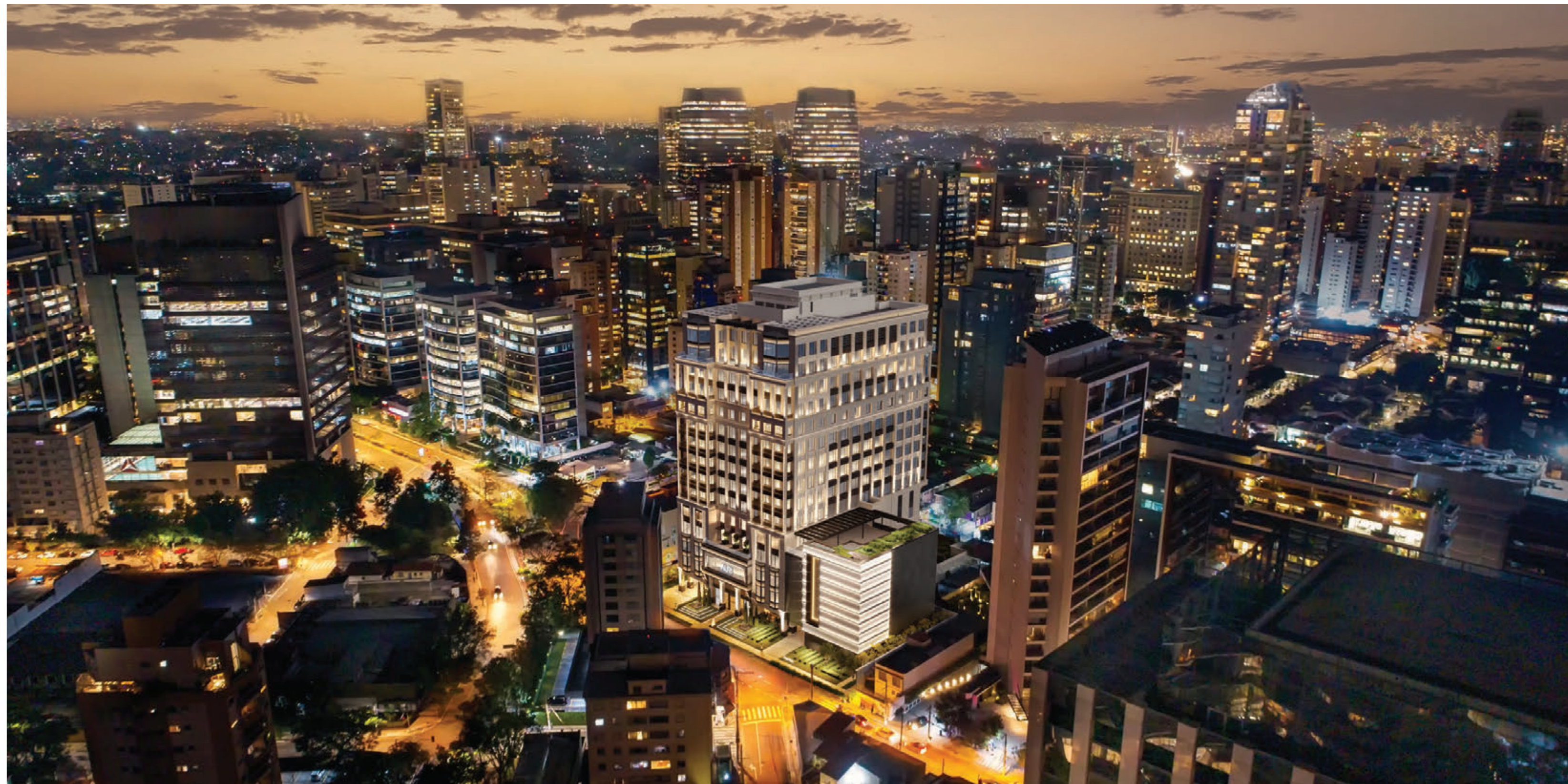
Foto aplicação do empreendimento
